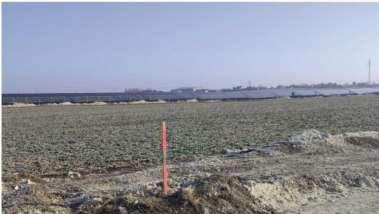
Fot. 2. Obecne zainwestowanie obszaru nr 1 o powierzchni 31,4941 ha zlokalizowanego na północ od budowanej drogi ekspresowej S12, widok od strony miasta Chełm
