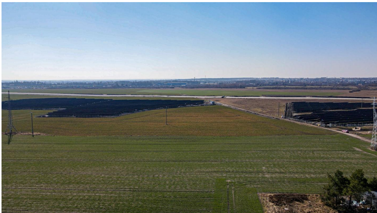
Fot. 1. Obecne zainwestowanie obszaru nr 1 o powierzchni 31,4941 ha zlokalizowanego na północ od budowanej drogi ekspresowej S12, widok od strony wsi Srebrzyszcze
