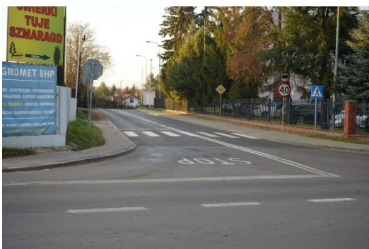
Ul. Mostowa po remoncie
