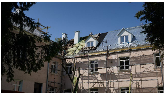
Szkoła w Okszwie – remont dachu OŚWIETLENIE
