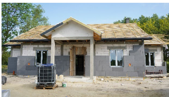
Budowa świetlicy w Rudce
